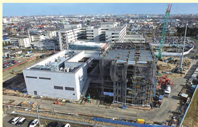
2017.1.28 第2教育研究棟は内部の仕上げ工事を行っています。 第1教育研究棟は引き続き、高層部の鉄骨建方を進めています。
