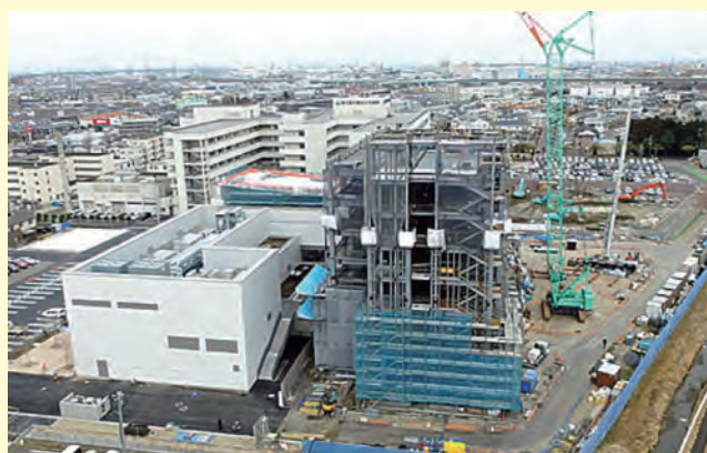
2017.2.22 第2教育研究棟は建物が完成し、機器備品の搬入を行っています。 第1教育研究棟は7階までの鉄骨建方が完了しました。
