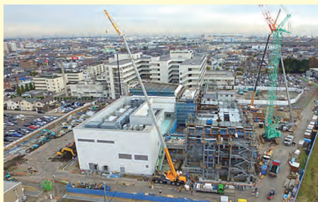
2016.12.26 第2教育研究棟は屋上および内部の設備工事を行っています。 第1教育研究棟は引き続き、高層部の鉄骨建方を進めています。
