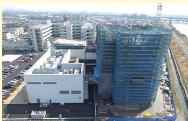
2017.3.31 第2教育研究棟は機器備品の搬入が完了し、使用を開始しました。 第1教育研究棟は低層部の外壁工事、高層部の床工事を行っています。
