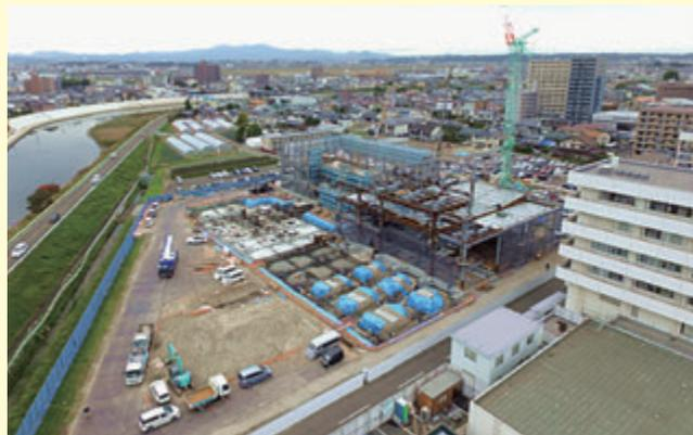
2016.10.28 第2教育研究棟は外壁工事、床工事を進めています。第1教育研究棟は低層部の鉄骨建方を行っています。
