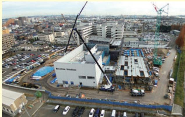
2016.11.28 第2教育研究棟は外壁が張られ、内部の設備工事を行っています。第1教育研究棟は高層部の鉄骨建方に着手しました。
