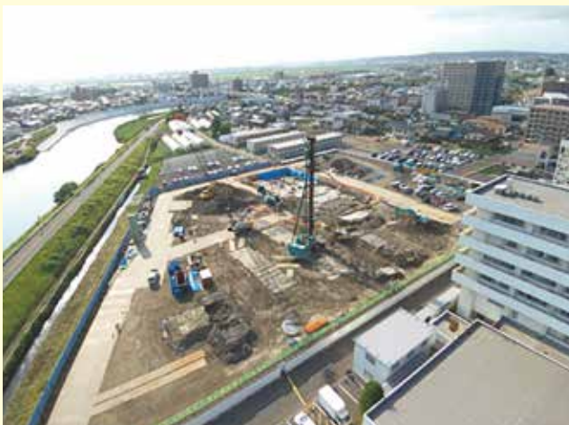
2016.6.20 第2教育研究棟の基礎工事に着手しました。
