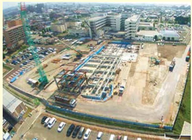
2016.7.29 第2教育研究棟低層部の鉄骨工事に着手しました。
