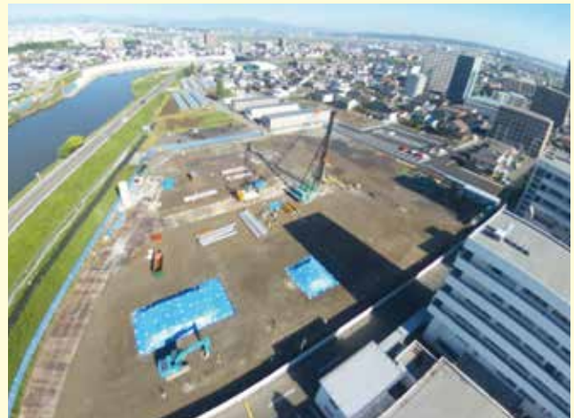
2016.5.18 建物を支えるための杭打ち工事を行っています。
